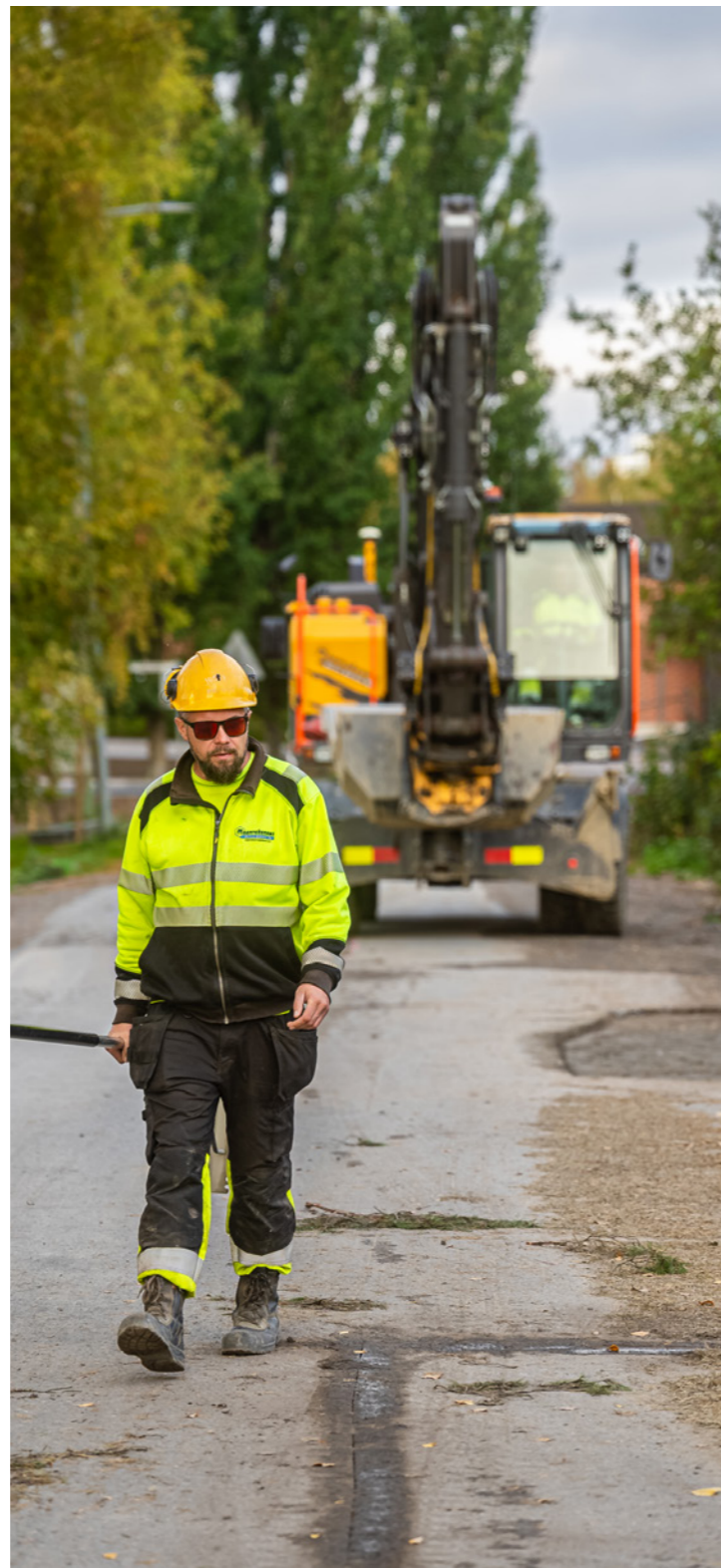
Herttualan menetelmäsaneerauskohteen kadun kaivu- ja tasoitustyöt käynnissä
