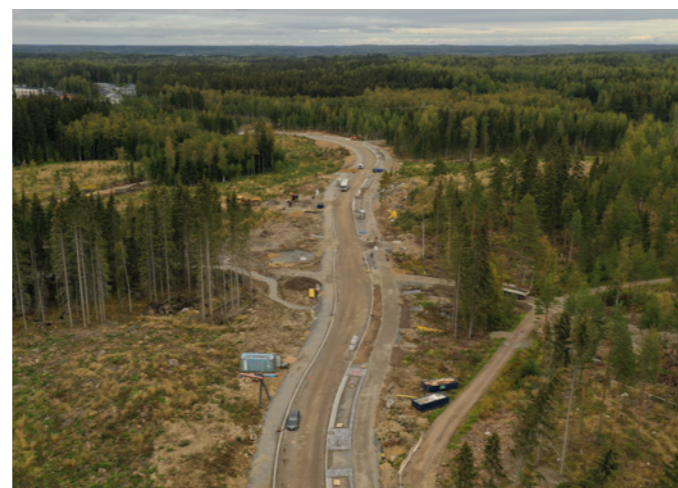
Lamminrahkan Rissonkadun rakentamisen alkuvaiheen ilmakuva
