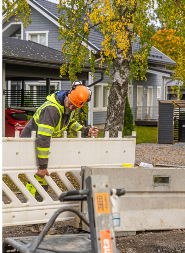
Herttulan saneeraustyömaan kaivannon suojaus
