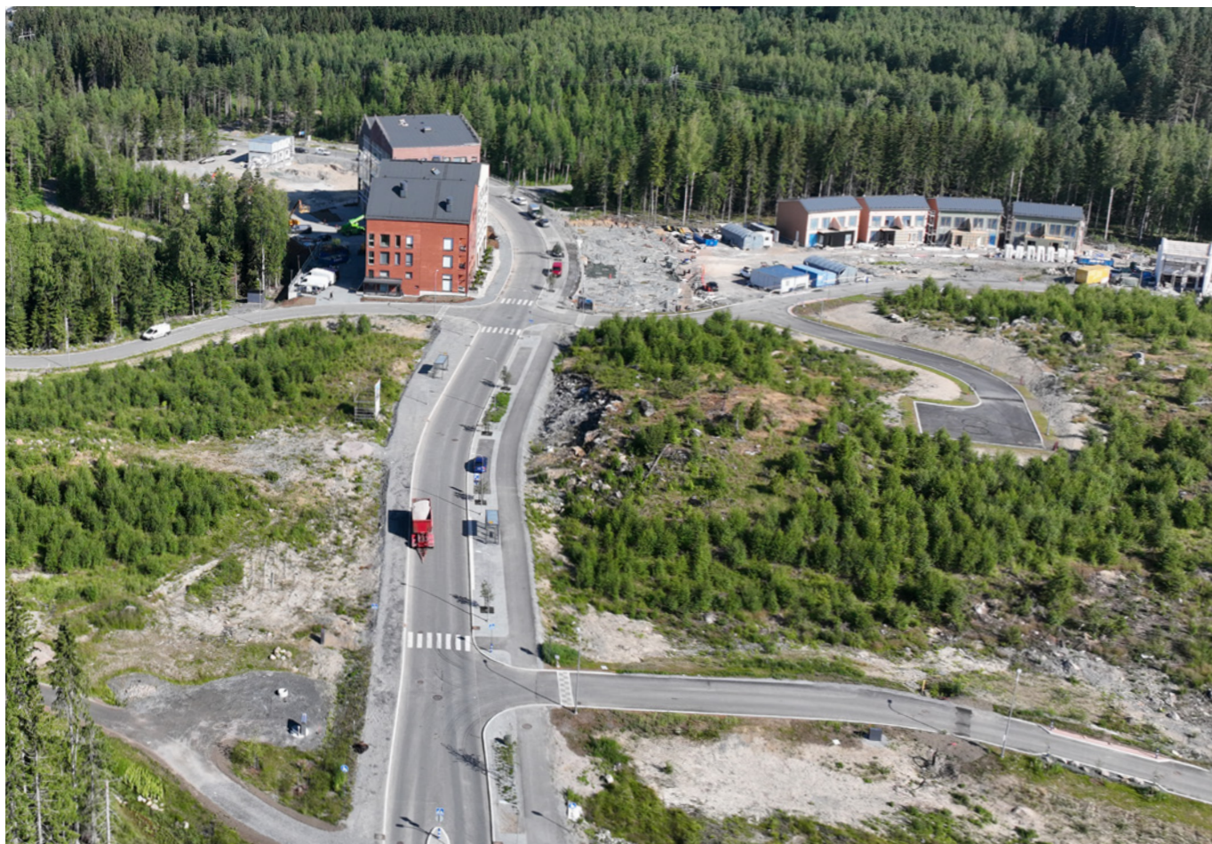
Lamminrahkan Rissonkadun ilmakuva länteen, kun katu valmiina
